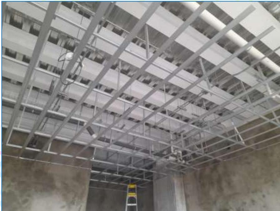
Vista interna de los ambientes, donde se observa los trabajos de instalación de la estructura para fijación del cielo falso, cableado del sistema eléctrico.
