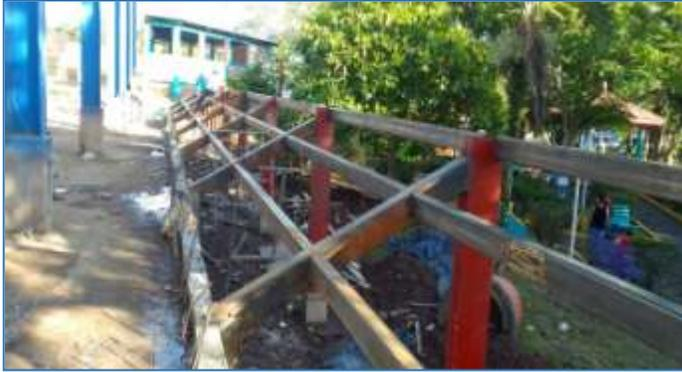
Vista panorámica de la estructura metálica principal de la gradería, donde se observan los elementos C-1, VM-1, VM-2
