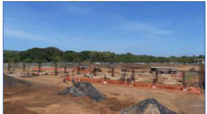
En ambas fotografías observar los avances en la ejecución de la etapa de fundaciones y estructura de concreto, específicamente en la colocación del acero de refuerzo y colado del concreto para las áreas gradería central (izquierda) y jardín derecho (derecha).
